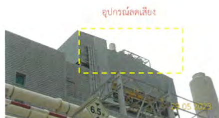
ภาพที่ 2-30 อุปกรณ์ลดเสียง (Silencer) บริเวณจุดระบายไอน้ำของหม้อไอน้ำ
