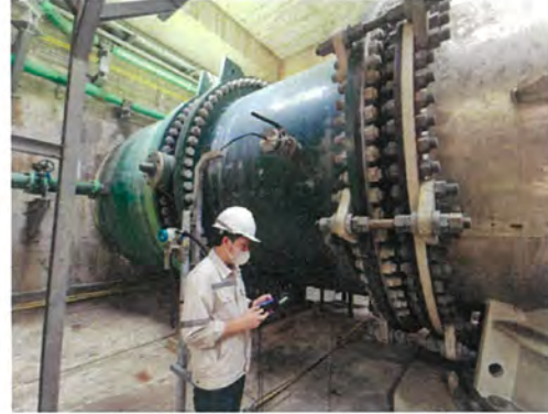
ภาพที่ 2-2 การตรวจวัดอัตราไหลของน้ำทะเล บริเวณจุดสูบน้ำทะเล
