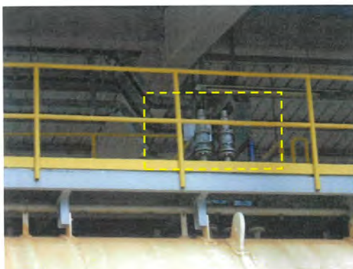
ภาพที่ 2-83 วาล์วลดความดันเพื่อป้องกันความเสียหาย ของถังแอมโมเนีย
