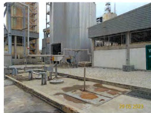
ภาพที่ 2-36 ระบบแยกน้ำมัน
