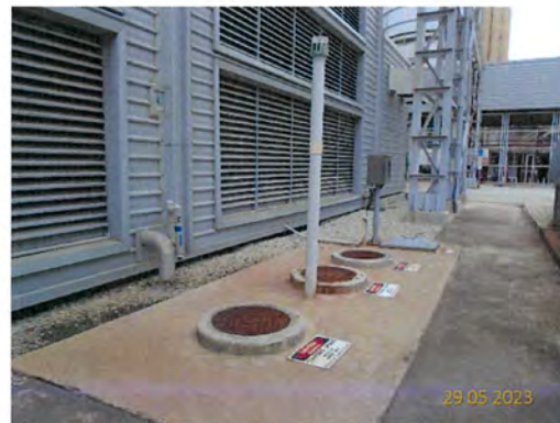
ภาพที่ 2-34 ถังบำบัดน้ำเสียสำเร็จรูป
