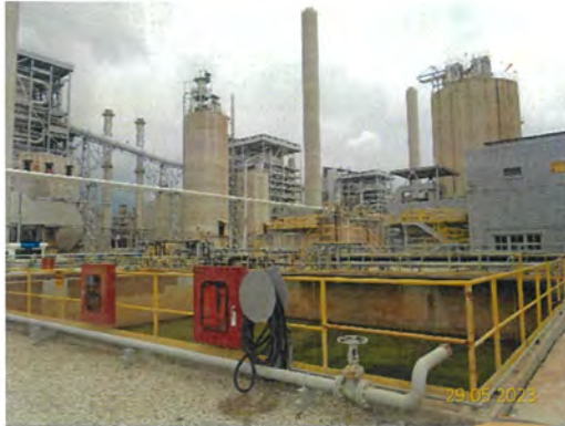
ภาพที่ 2-37 บ่อพักน้ำทิ้งฉุกเฉิน (Abnormal Pond หรือ Retention Basin)
