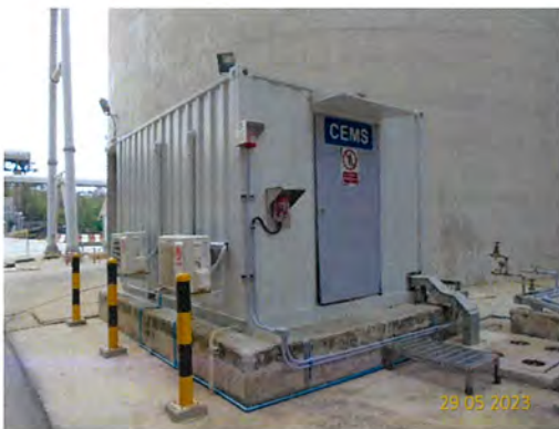
ภาพที่ 2-21 CEMS Analyzer
