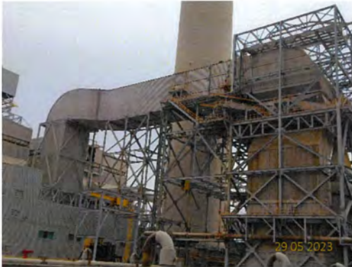
ภาพที่ 2-19 อุปกรณ์ควบคุมก๊าซซัลเฟอร์ไดออกไซด์ (SW-FGD)
