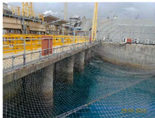
ภาพที่ 2-46 อุโมงค์น้ำเข้าเครื่องสูบน้ำ
