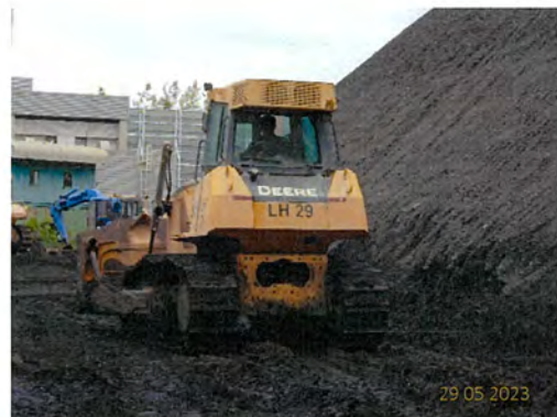
ภาพที่ 2-10 การบดอัดกองถ่านหิน
