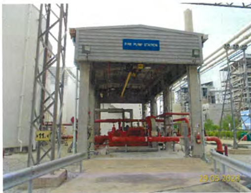
ภาพที่ 2-81 ระบบสูบน้ำดับเพลิง
