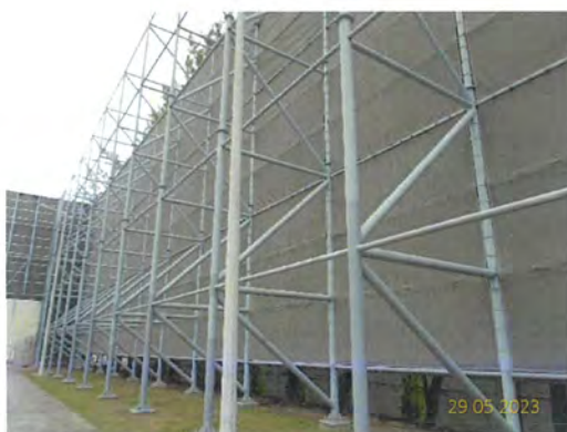
ภาพที่ 2-15 กำแพงกันลมรอบลานกองถ่านหิน
